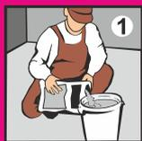
1 Для приготовления раствора залейте водопроводную воду комнатной температуры в чистую ёмкость из расчёта 0,5 л на 1 кг сухой смеси (на 1 мешок 5 кг – 2,5 л воды).
